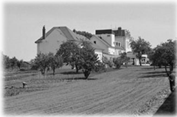
Bâtiment initial élevé 1900
